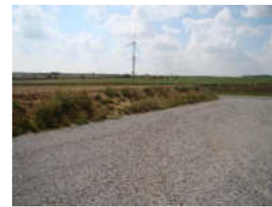
Végétation non entretenue se développant sur les talus d'une plateforme construite en déblais ©Ecosphère
