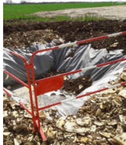
Coulage béton dans une zone aménagée. ©Écosphère
