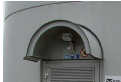
Entrée d'éolienne avec spot à détection de présence. @ F. Caron - Ecosphère
